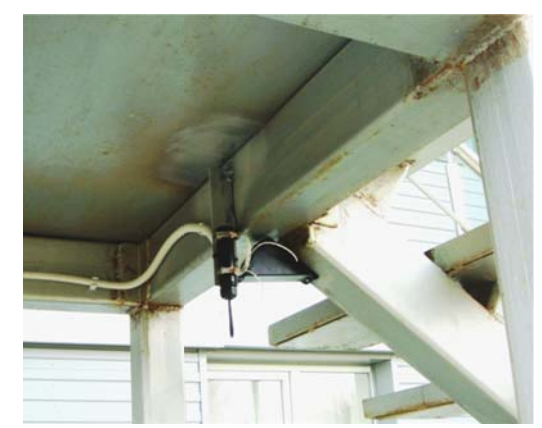
Крепление сенсора СПВ-1Г с УК по варианту В (фото с объекта).
