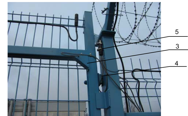
Фото установленного в углу каркаса ворот сенсора СПВ-1Г с узлом крепления
